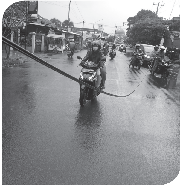
KABEL MENUUNTAI DI JALAN
